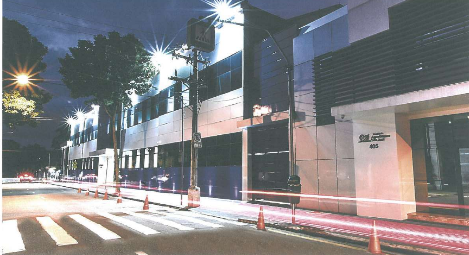
Fachada | Unidade I
