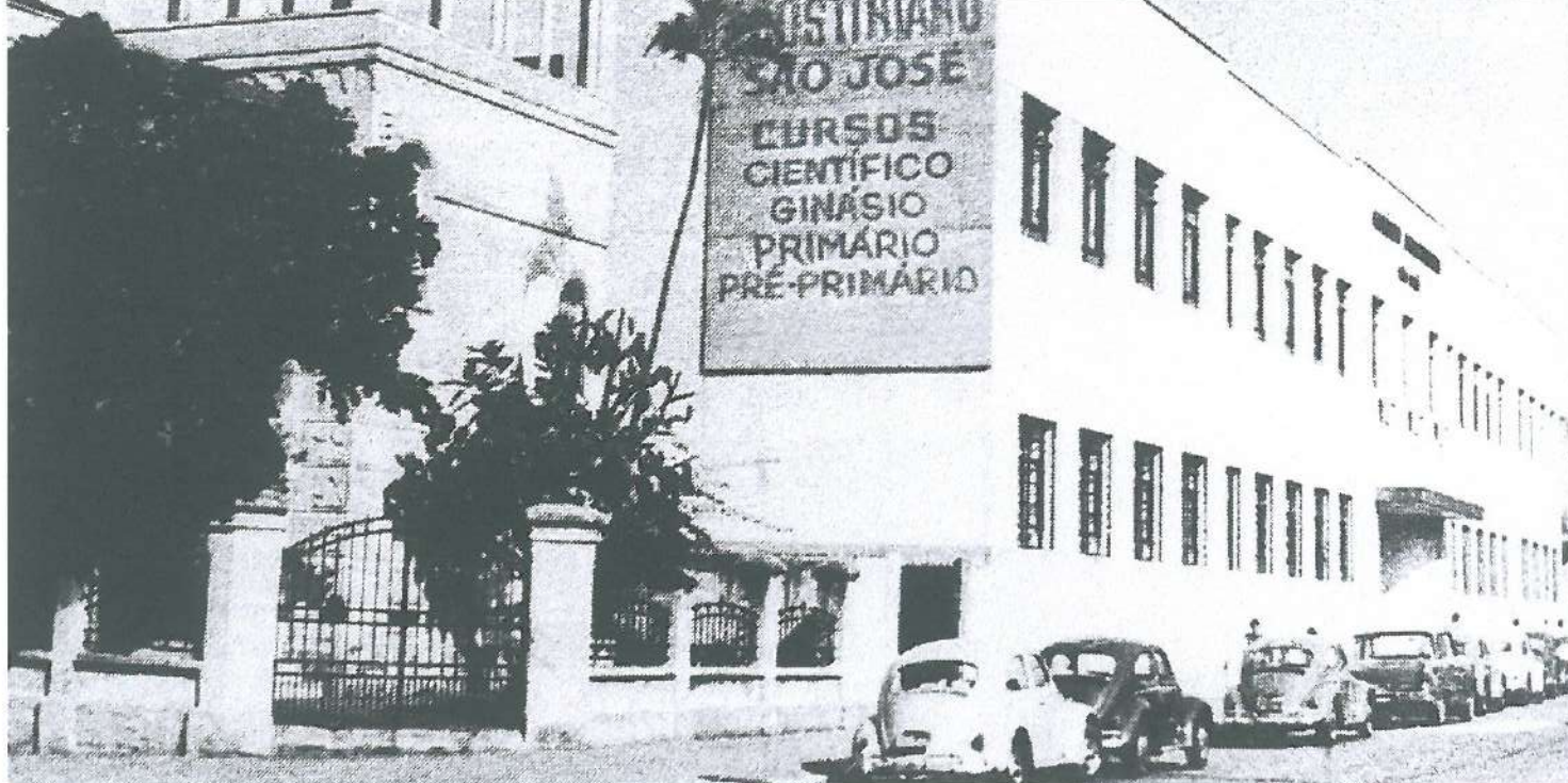
Fachada | Unidade I | Década 1960
