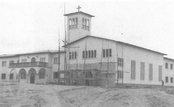
Última fase da construção: Capela e pavilhão sul
