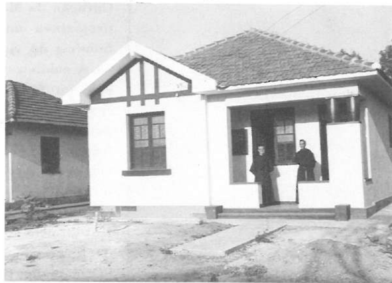
A casa nº 81 da Rua 55, com os Padres Alípio e Modesto
