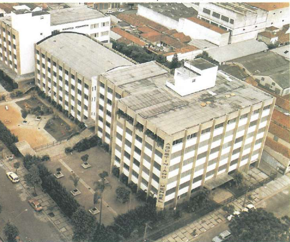
Edifício do Colégio Agostiniano Mendel
