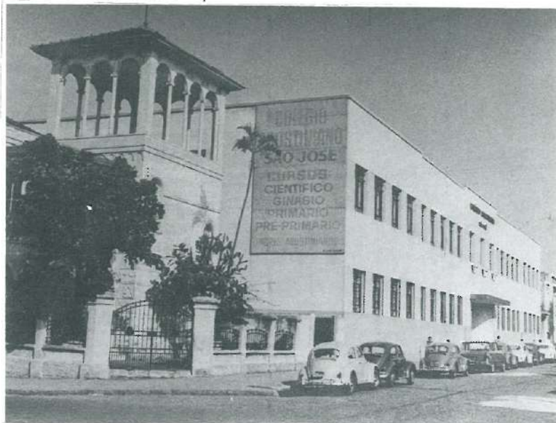
Primeira reforma do prédio "Moinho Santista S.A."
