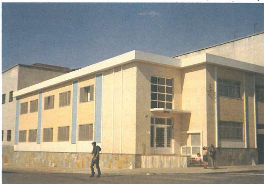
Reforma da residência
