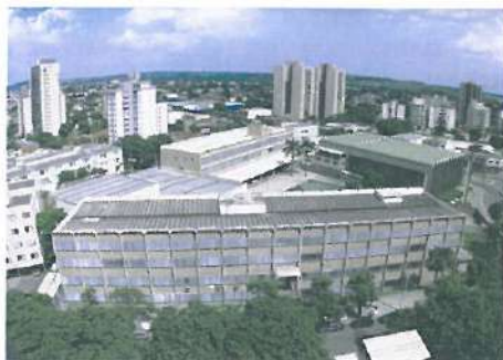
VISTA AÉREA DO COMPLEXO DO COLÉGIO AGOSTINIANO NOSSA SENHORA DE FATIMA
