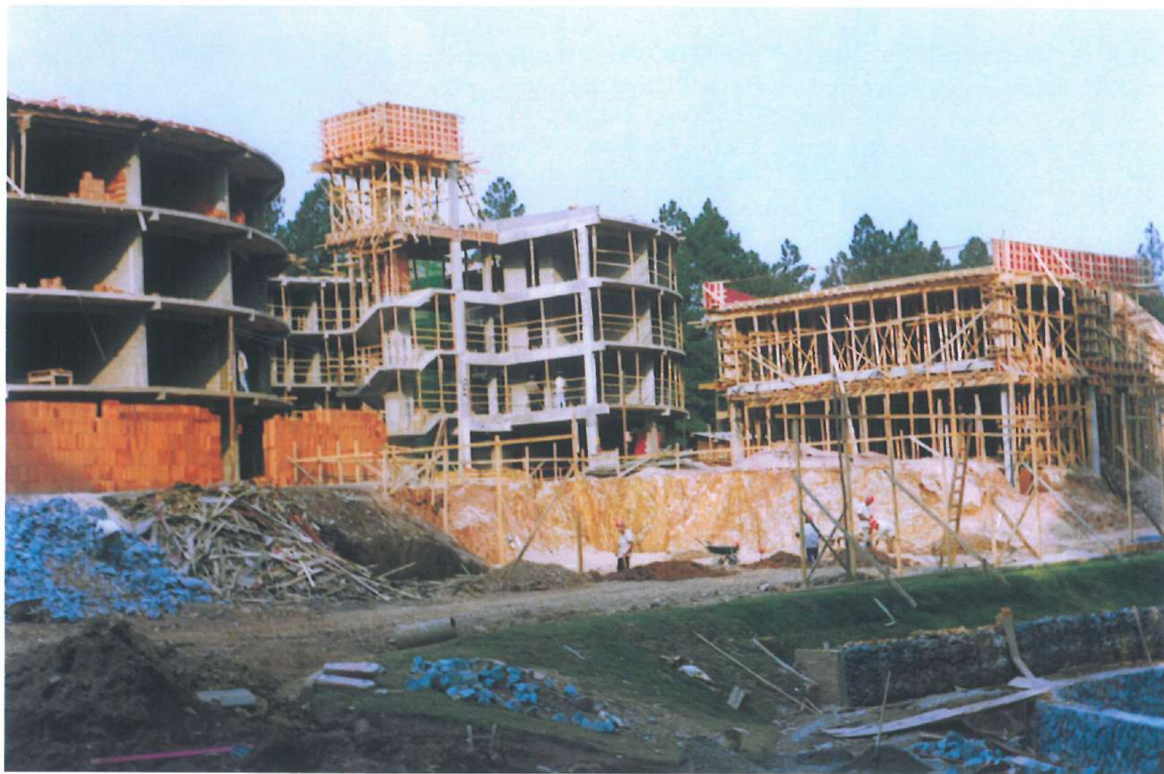
Construção do Conjunto Hipona | Guarulhos - SP Década de 90
