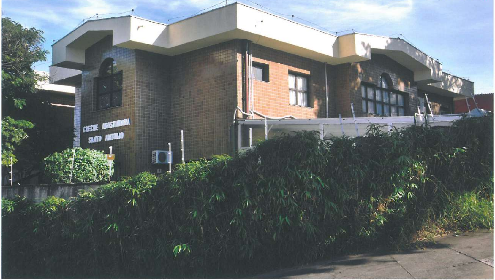
Fachada da Creche Agostiniana Santo Antônio Campinas - SP
