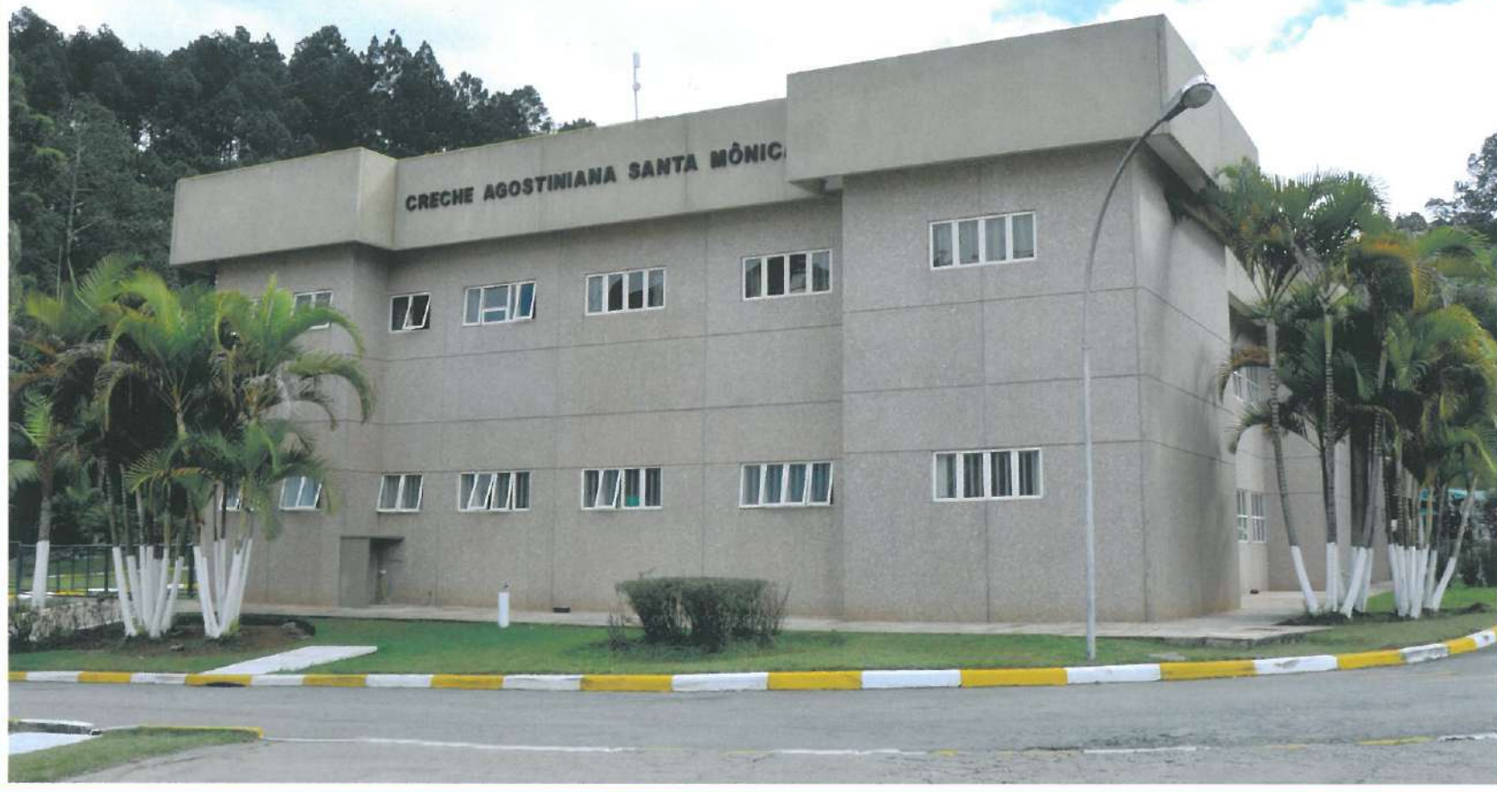
Fachada da Creche Agostiniana Santa Mônica Guarulhos - SP
